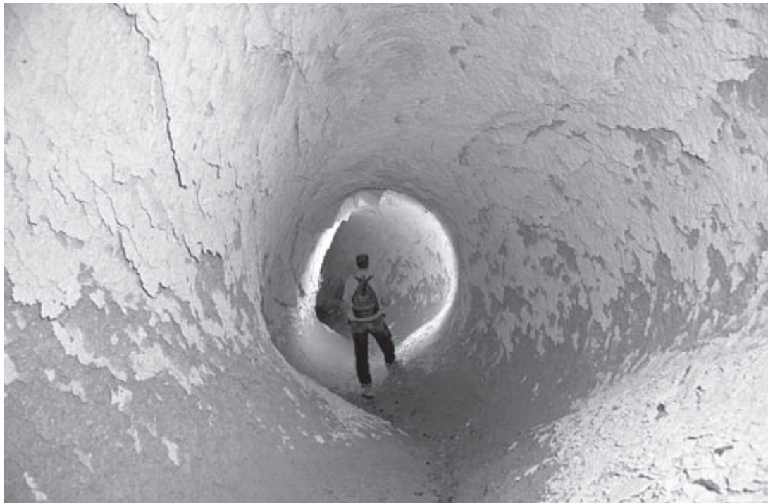
Fig. 33 – Meskendir Vadisi: sezione di un canale di drenaggio pertinente una valle laterale con evidenza della sezione tondeggiante dovuta essenzialmente alla esfoliazione.
