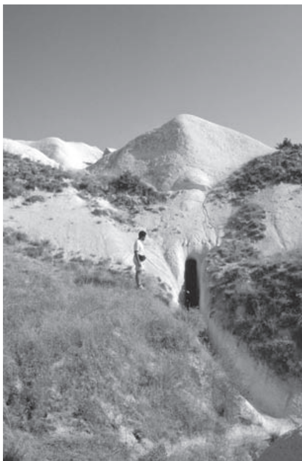
Fig. 27-28 – 27. Meskendir Vadisi: tratto intermedio del collettore centrale interessato da fenomeni di crollo che hanno alterato totalmente la conformazione morfologica originale; 28. Cunicolo di drenaggio pertinente una diramazione laterale della valle rimasto sospeso ed inattivo.
