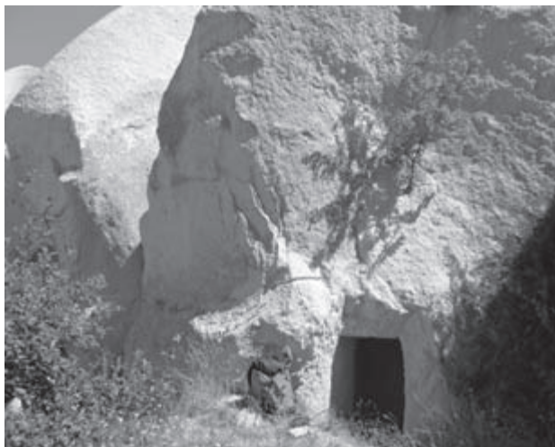
Fig. 29 – Meskendir Vadisi cunicolo di drenaggio pertinente una diramazione laterale della valle rimasto sospeso ed inattivo. La differente conformazione del cunicolo deriva dall'essere questo pertinente un tratto non più in esercizio. L'interramento da detrito è comunque notevole.
